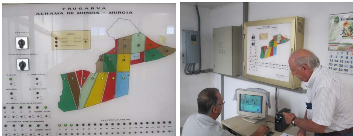
Fotografías 1y 2. Distribución de parcelas en la Finca El Aguilucho y control automatizado de la fertirrigación por goteo
